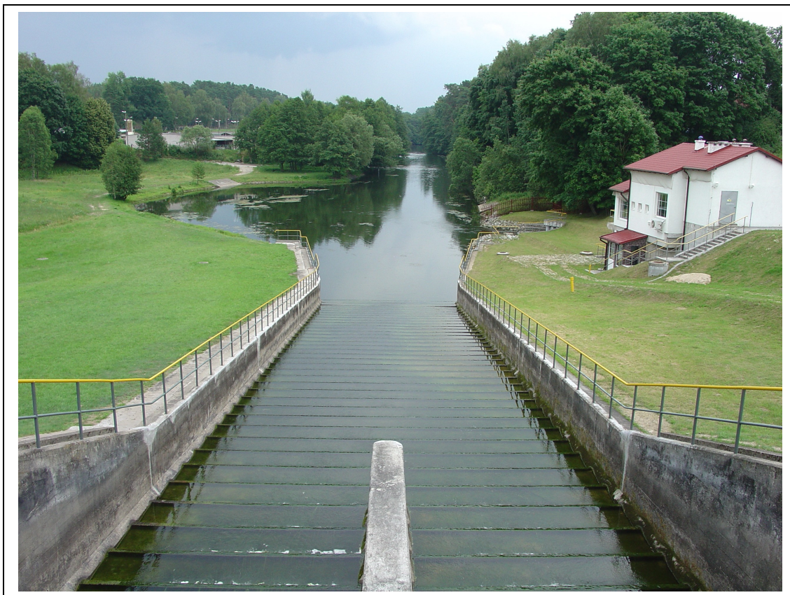
Zdjęcie 37. Zapora w Myłofie - widok na przelew skarpowy
