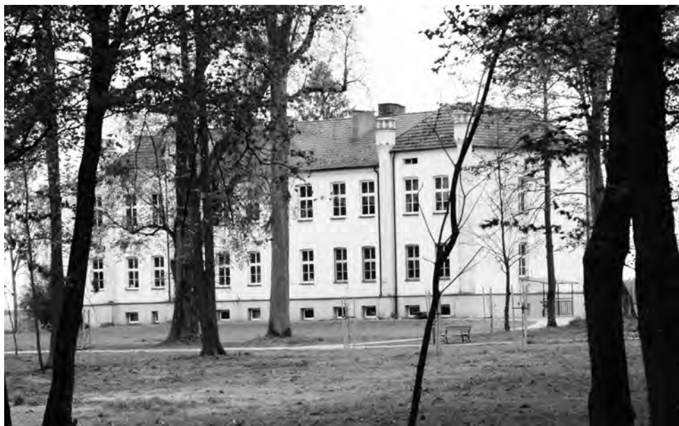
Dwór Sikorskich w Wielkich Chełmach - stan obecny.
