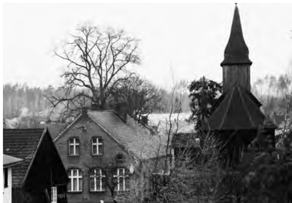
Kościół w Sominach. Widok od strony cmentarza.
